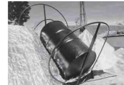
Mangueira de polietileno sendo usada para sustentar o plástico
