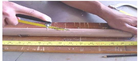
4. Uma vez realizados os dois cortes e retirada a tira, dar acabamento com a lixa nas superfícies cortadas e arredondar, com lima redonda, as extremidades do rasgo, levando para a largura original da placa alveolar, de 61,5 cm. Em seguida limpar com álcool.
