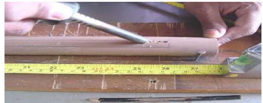
3. Introduzir a ponta da lâmina da serra e iniciar o corte. Faça movimentos lentos seguindo a marcação, a fim de não abrir um rasgo maior ou menor do que o necessário. Nas pontas do rasgo, fazer cuidadosamente um corte transversal para poder retirar a tira de PVC.
